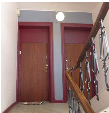
Karmene står igjen, men dørene er skiftet ut og glassfeltet øverst tettet igjen. Her ligger det til rette for å lage nye og bedre tilpassede dørblader.
