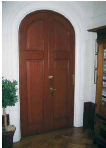
Flere dører på Nobel-instituttet i Oslo er blitt oppgradert til høyere brannklasse ved hjelp av brannmaling. Dørene fremstår som før etter behandlingen.
