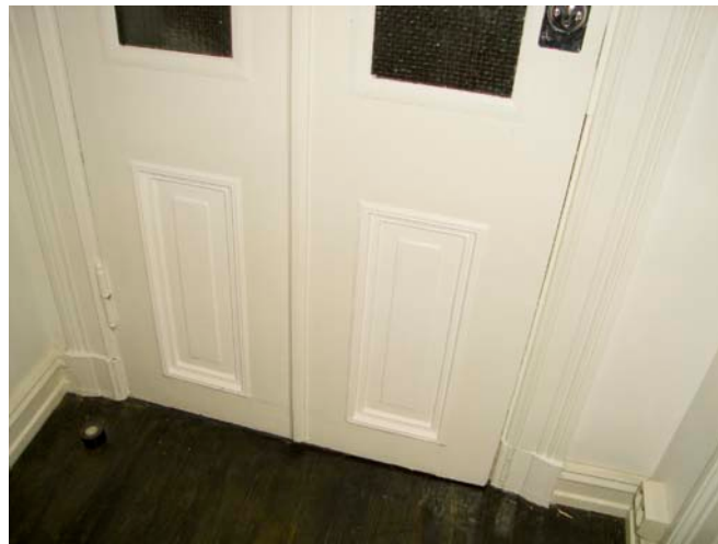
Nye glasslister (malt aluminium) og brannhemmende maling på speil, innvendig.
